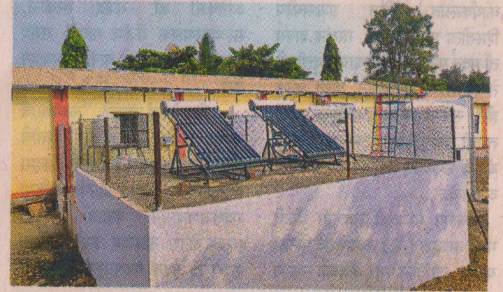
नांदल (ता. फलटण) : शाळेच्या इमारतीवरील रेन वॉटर हार्वेस्टिंग, पाण्याच्या टाकी आणि निंबकर कृषी संशोधन संस्थेने (नारी) बसविलेली सौर ऊर्जेवरील पाणी शुद्धीकरण यंत्रणा.
